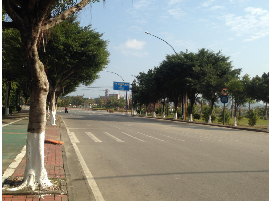
项目拟建终点与东侧沿江东路
