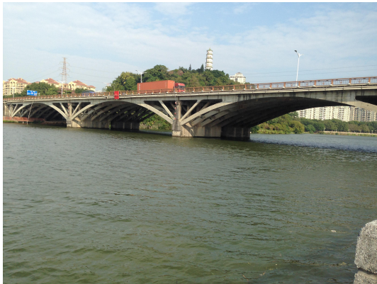
项目上方雁塔桥与西侧增江
