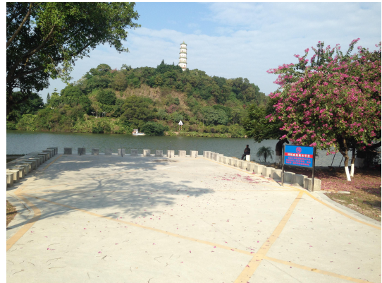
项目西侧消防应急取水平台
