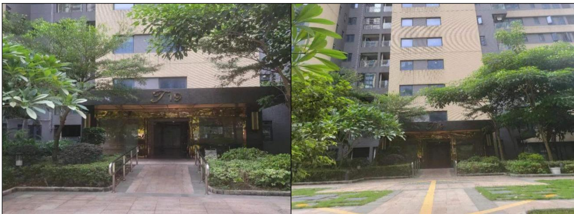
中铁十二局原项目部，租用现有民房，现已归还。
