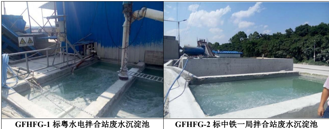
图7.2-7 项目施工期环水保设施设置图
