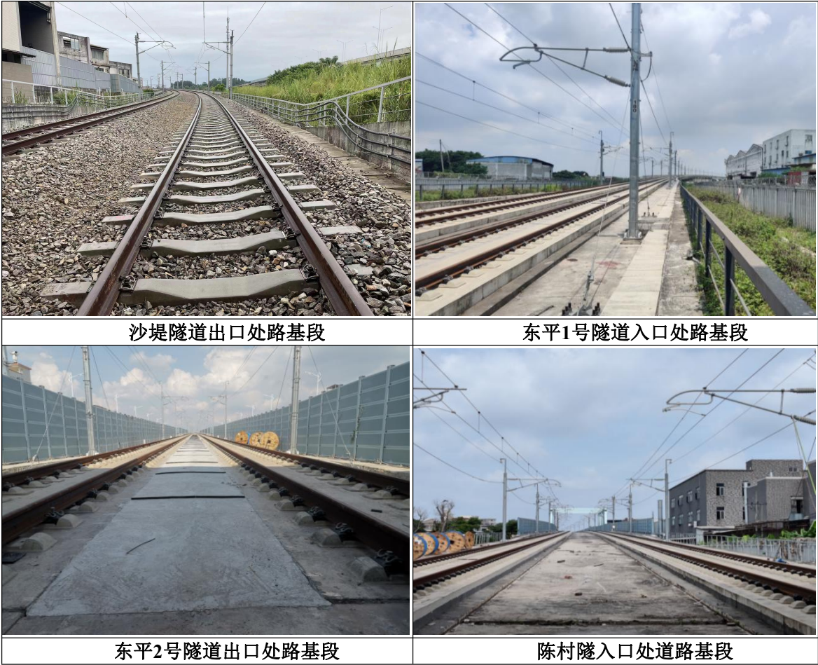
图 7.2-3 本工程路基工程现场照片
