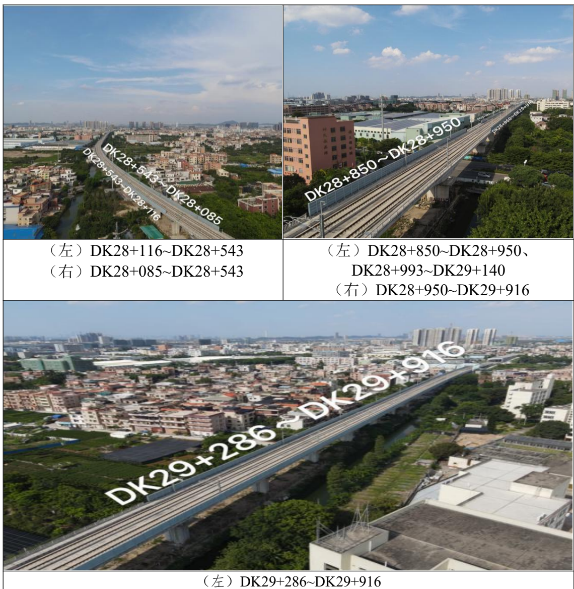
7.3-1 本项目声屏障设置现场图片
