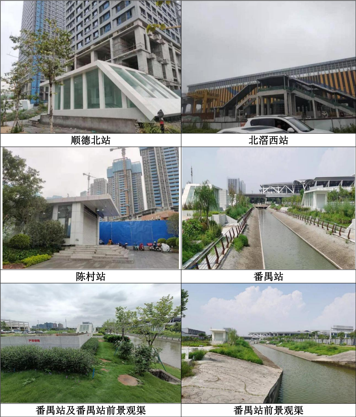
图 7.2-5 本工程车站现场图片
