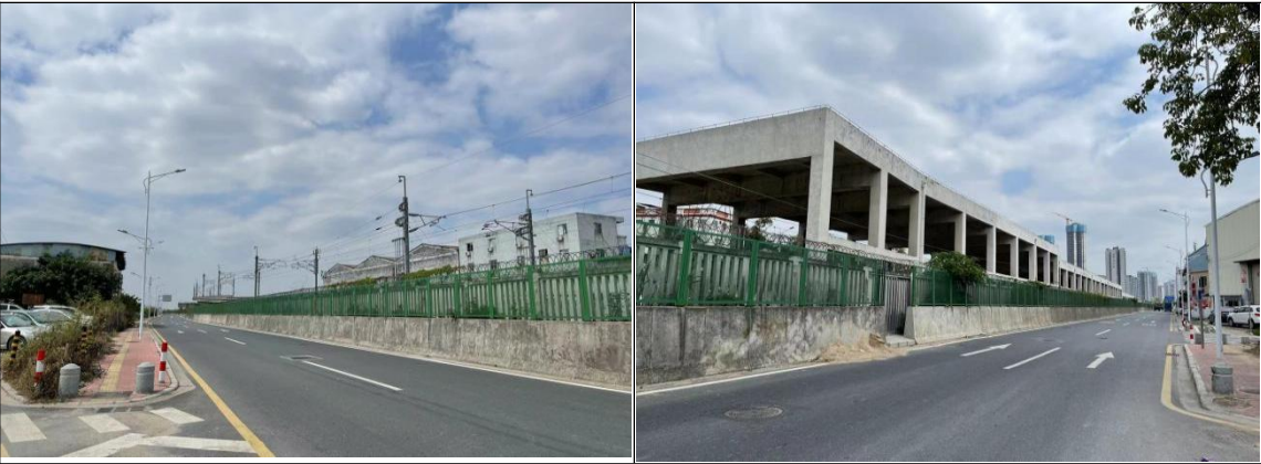
原1标段施工临时便道现状图
