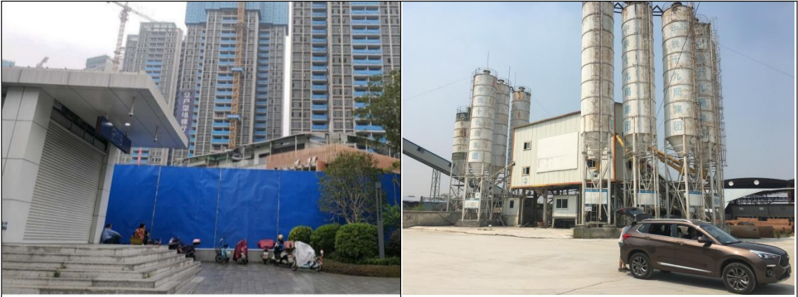
3标华隧原拌合站，现已移交归还 3标中铁十九局原拌合站，现已移交归还 图 7.2-6 本工程原施工所设混凝土拌合站用地现状图片
