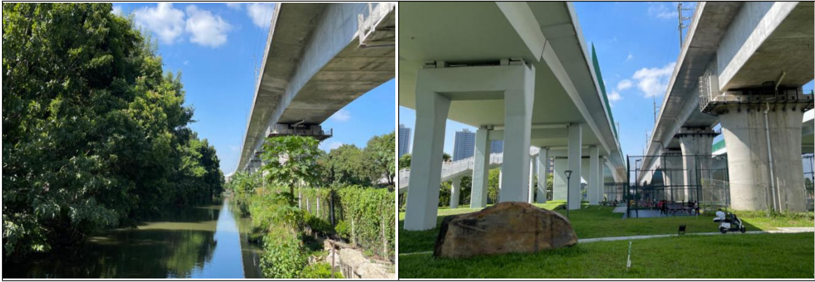
图 7.2-2 沿线桥梁工程实施后现场情况
